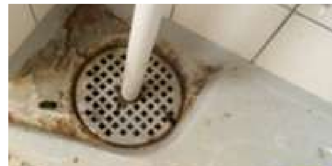
Det oprindelige gulv afløb i badeværelser er placeret i hjørne under håndvask.
